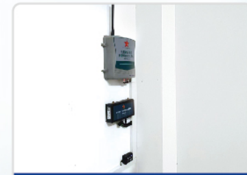
设备实景安装场地
