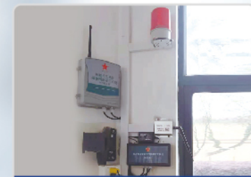
设备实景安装场地
