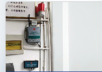
设备实景安装场地
