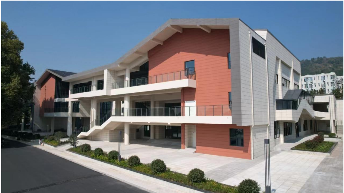
厂区现状照片
